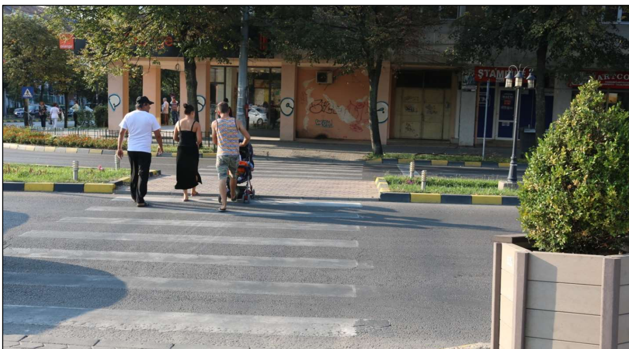
Figura 2.39. Tregeri de pietoni accesibilizate.
