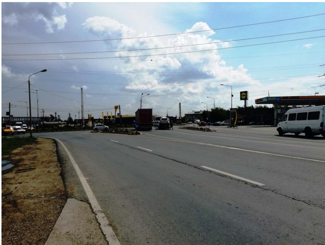
Fig. 4.11. Str. Cuza Vodă - Calea Moldovei - imagine intersecție
