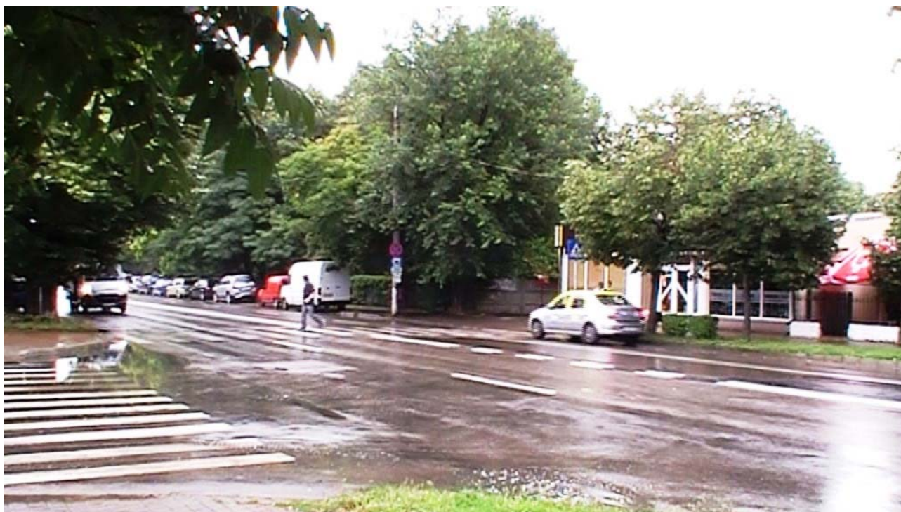
Fig. 4.33. Str. Cuza Vodă - Str. Ana Ipătescu - imagine intersecție
