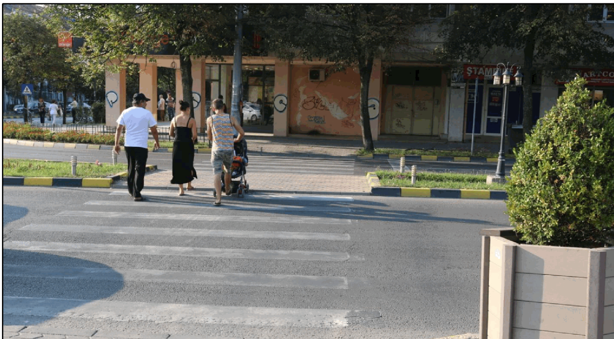
Figura 2.39. Tregeri de pietoni accesibilizate.
